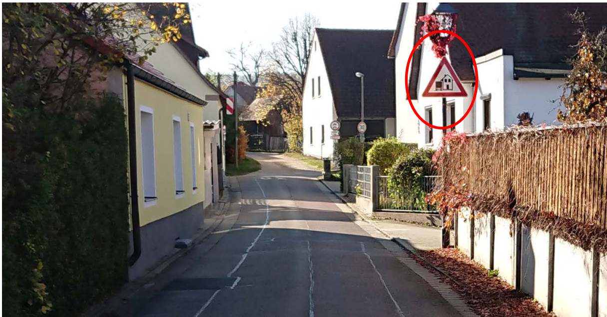
Abbildung 20: Straßenraum im Nördlichen Stadtgraben in Richtung Südwest
