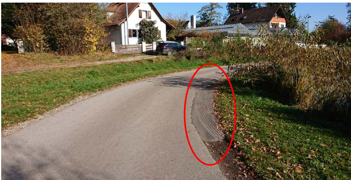
Abbildung 17: Weg entlang des Stadtweihers mit Bankettenutzung und fehlender Kurvenaufweitung
