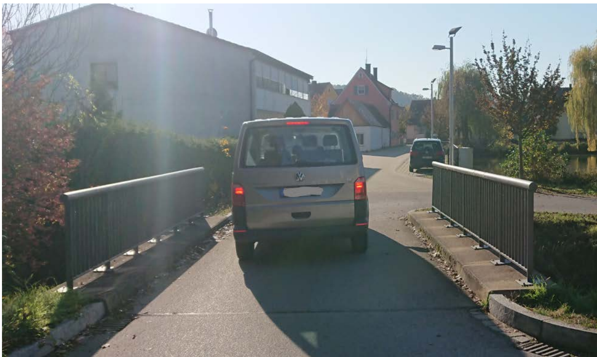
Abbildung 15: Brücke über die Roth mit Nutzung durch Kfz-Verkehr
